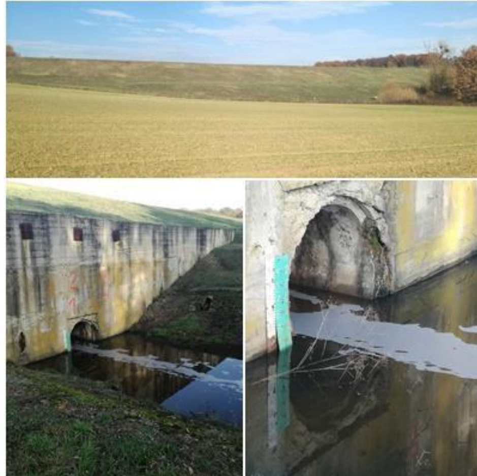
Hrádza a výpust pod hrádzou odkaliska Poša
