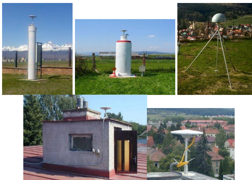
Obr. 2.3: Ukážky niektorých staníc SKPOS. (Zdroj: Informácie o službe, 2019; upravené autorom).
