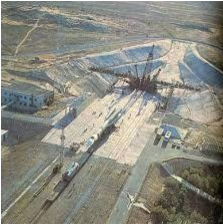
Štartovací komplex pre rakety Sojuz.
