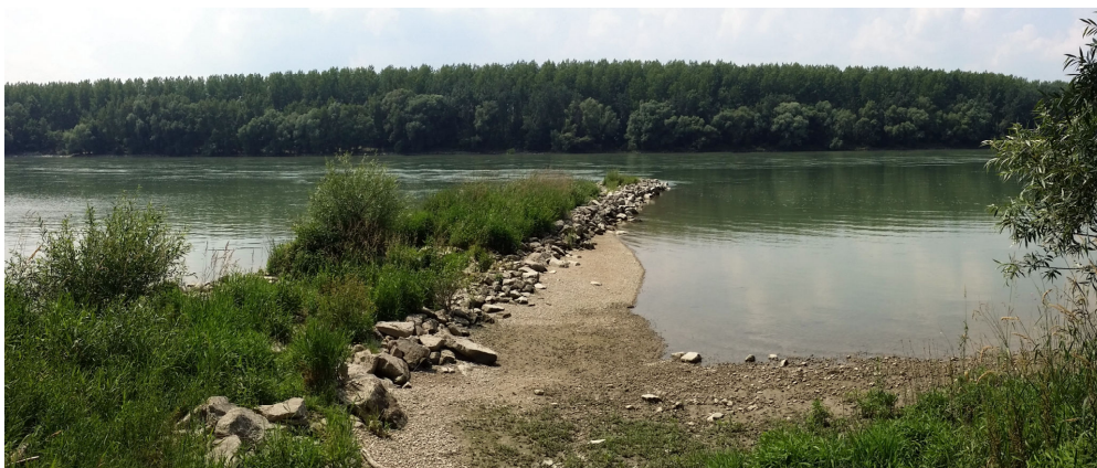
Obr. 15. Jeden zo súčasných výhonov, vybudovaných v 20. storočí. Medveďov, foto: P. Pišút 6. 6. 2018
