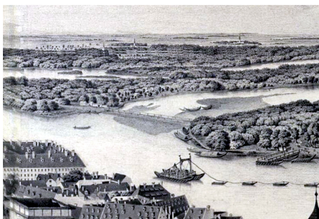
Obr. 7. Uzatváracia hrádza Chorvátskeho ramena bezprostredne po dokončení. Detail z obrazu L. Janschu (č. 7 v Zozname) ukazuje štrkopieskové nánosy, ktoré sa usadili v ústí ramena v priebehu jeho uzatvárania a tesne po ňom. Zároveň zreteľne vidno, že aj táto cesta na korune prehrádzky bola z oboch strán istená dreveným zábradlím (porovnaj obr. 6 – A B). V popredí „lietajúci“ most.
