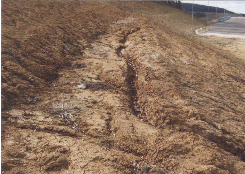
Obr. 8. Erózia na dolnom stupni svahov (6.12. 2012)
