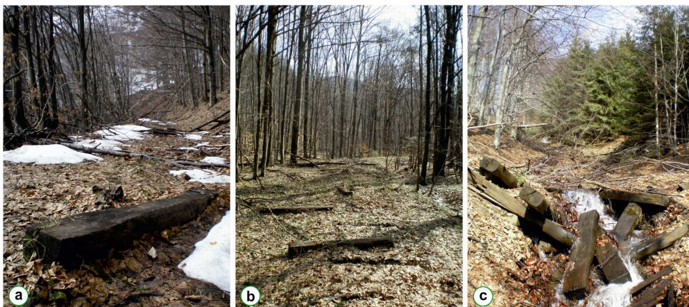
Obr. 1. Stav železničného násypu lesnej úzkokoľajovej železnice na trati Remetské Hámre – Morské oko (dokumentované 25. 3. 2012); a, b) zreteľný železničný násyp so zachovanými podvalmi v strednej a hornej časti trate, c) naplavené zvyšky železničných podvalov v oblasti Kvapka
