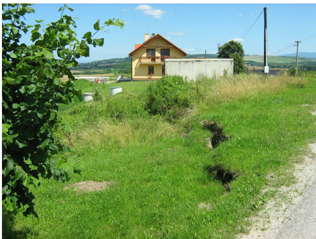
Obr. 2. Odtrhová zóna v hornej časti svahu v obci Nižná Myšľa
